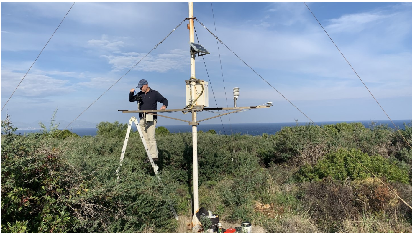
Εικόνες 1.2-2: Απο τις τεχνικές εργασίες στον σταθμό ΖΚΤ-3 στις 16/11/2021.
